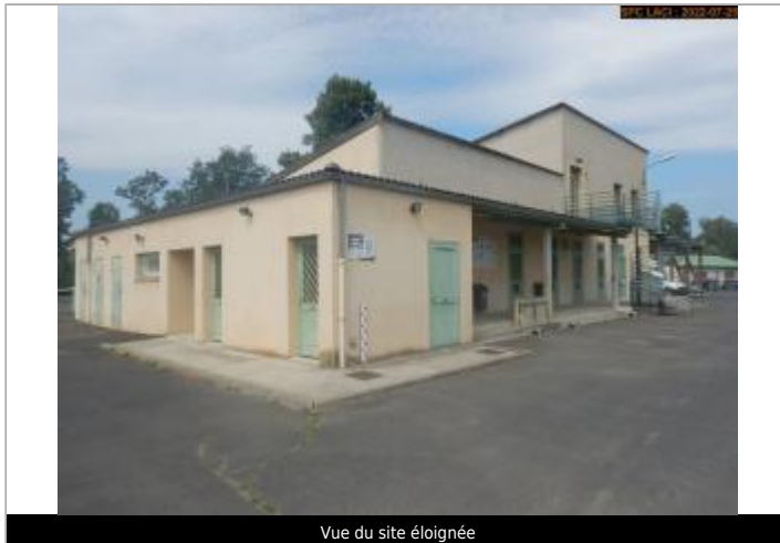
Vue du site éloignée
