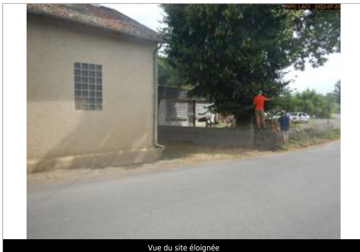
Vue du site éloignée
