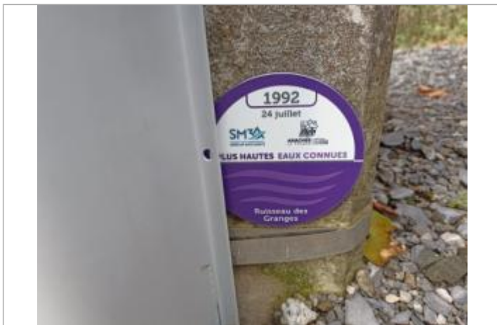
crue du ruisseau des Granges le 24 juillet 1992
