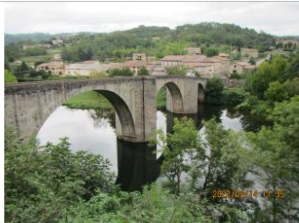
Pont de Chambonas (face aval)
