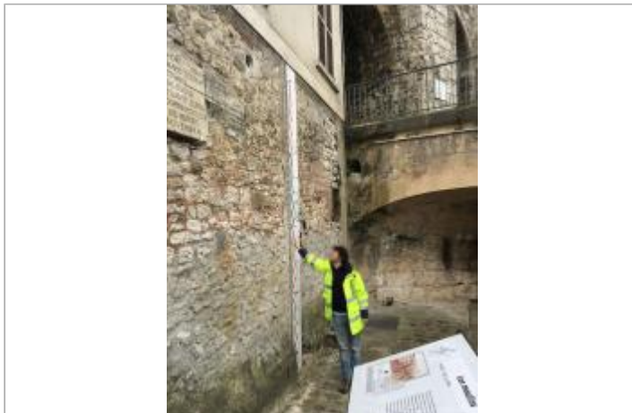
Vue du site - Auteur : SPC SMYL
