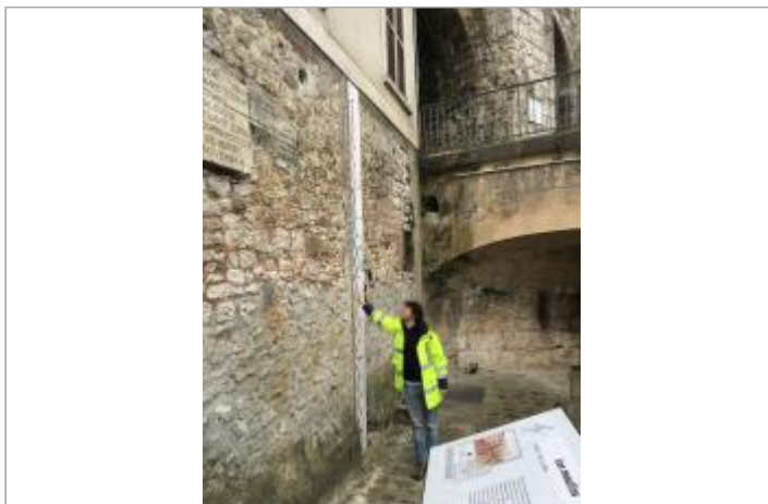
Vue du site - Auteur : SPC SMYL
