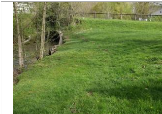
Vue site - Auteur : SPC SMYL
