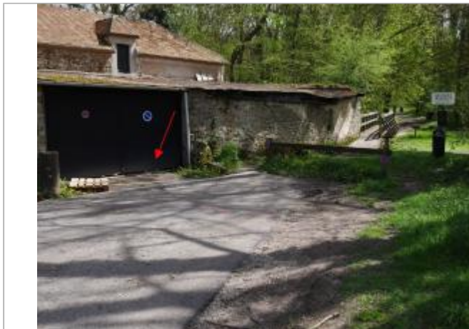
Vue site - Auteur : SPC SMYL
