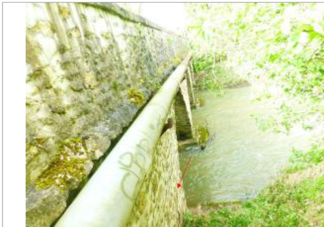
Vue site - Auteur : SPC SMYL
