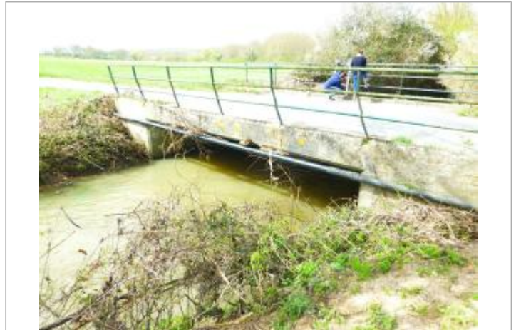
Vue site - Auteur : SPC SMYL
