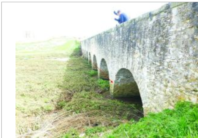
Vue site - Auteur : SPC SMYL
