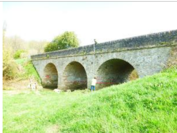
Vue site - Auteur : SPC SMYL
