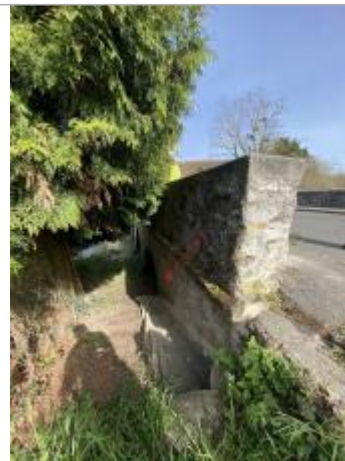
Vue site - Auteur : SPC SMYL
