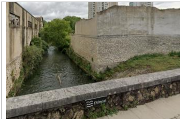
Vue site - Auteur : SPC SMYL
