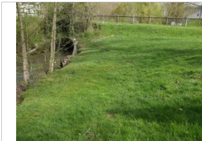
Vue site - Auteur : SPC SMYL
