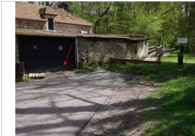
Vue site - Auteur : SPC SMYL
