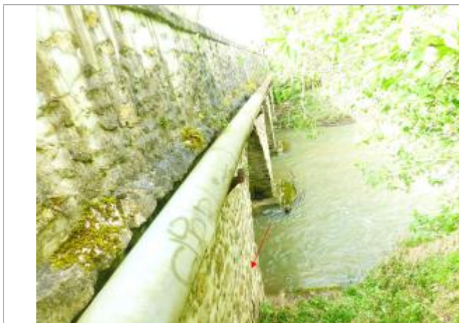
Vue site - Auteur : SPC SMYL
