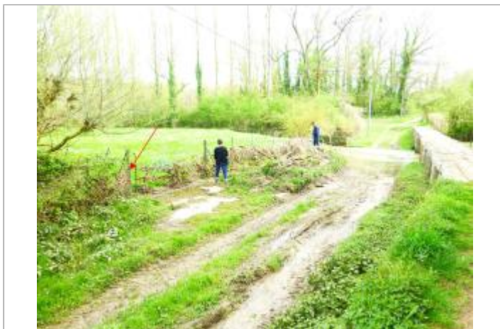
Vue site - Auteur : SPC SMYL
