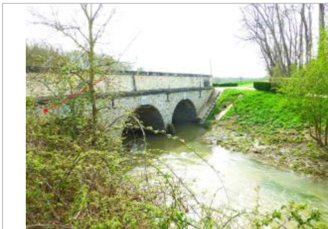
Vue site - Auteur : SPC SMYL
