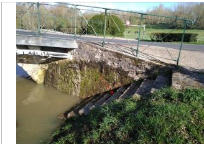
Vue site - Auteur : SPC SMYL
