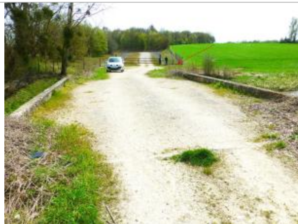
Vue site - Auteur : SPC SMYL
