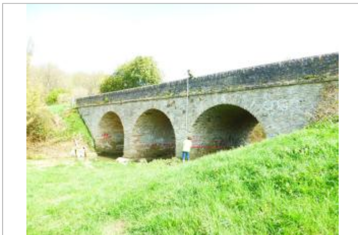
Vue site - Auteur : SPC SMYL
