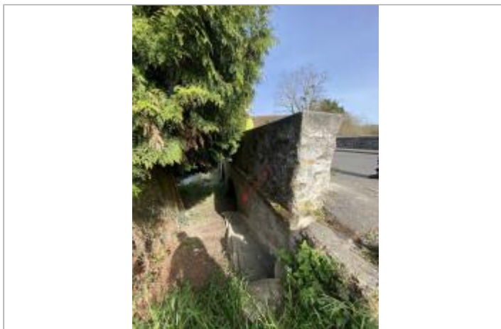
Vue site - Auteur : SPC SMYL
