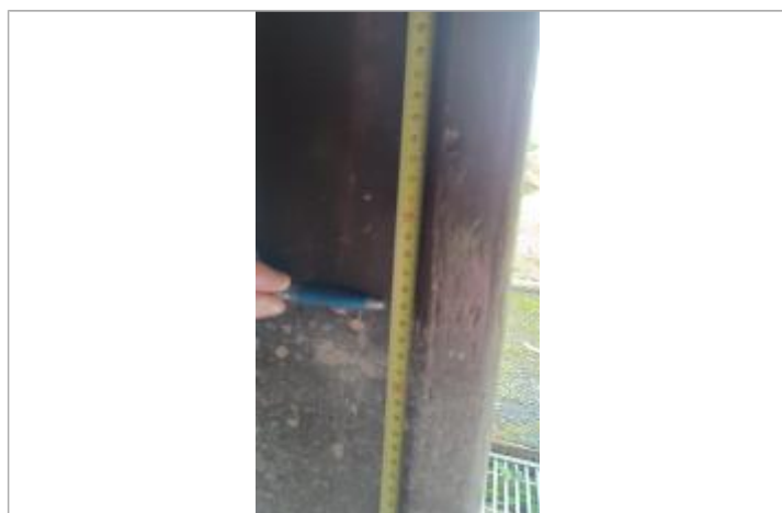
Laisse de crue à 65.5 cm/sol
