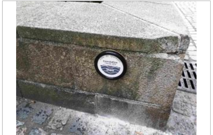
Muret espace public - Entrée Nord place Terre-au-Duc
