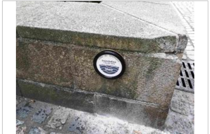
Muret espace public - Entrée Nord place Terre-au-Duc
