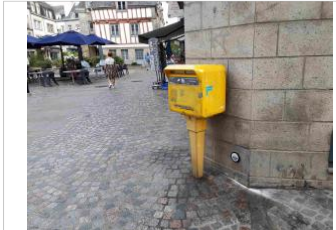
Bâtiment angle des rues Herse et Astor
