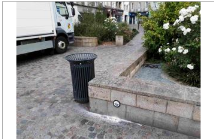
Muret espace public - Centre place Terre-au-Duc
