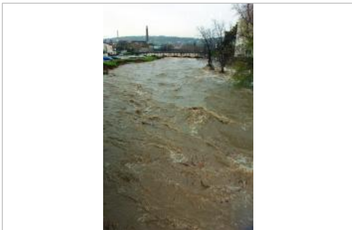
photo d'inondation sur le pont SNCF
