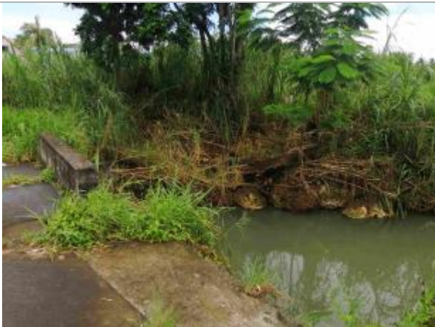
Ouvrage de franchissement en charge
