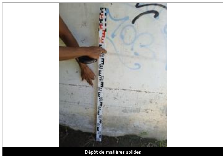
Dépôt de matières solides
