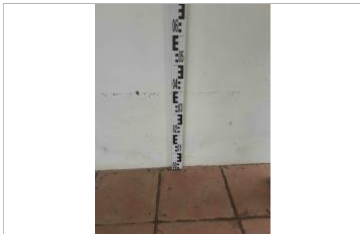
Dépôt de matières solides
