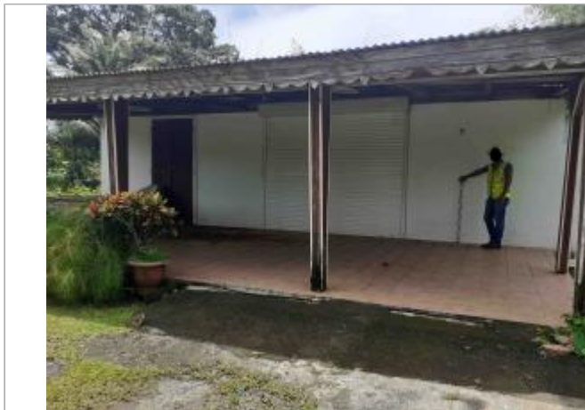
Façade extérieure du bâtiment
