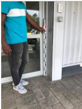
Dépôt de matières solides
