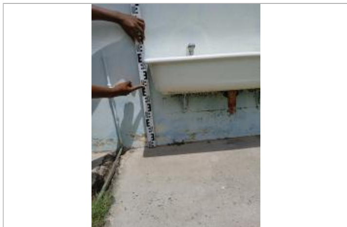
Dépôt de matières solides
