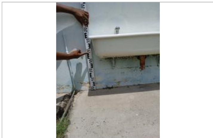
Dépôt de matières solides
