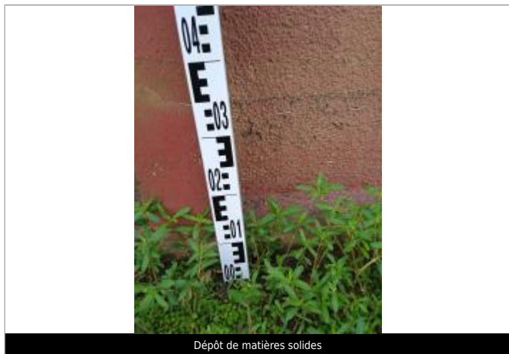
Dépôt de matières solides
