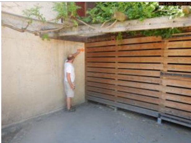
Vue du repère éloignée extérieure
