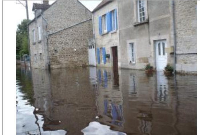
Vue d'ensemble de la laisse de crue (Source : DDT 61).
