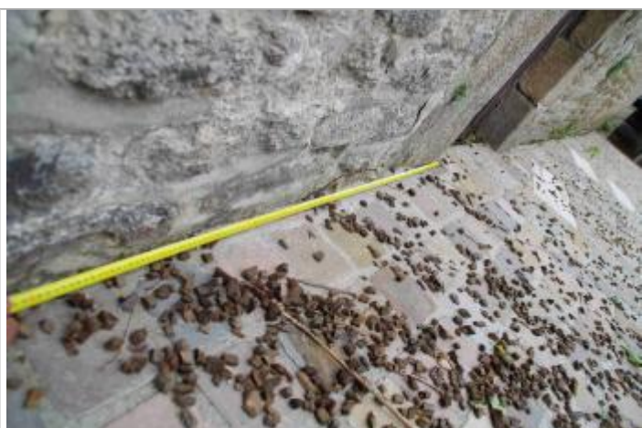
Vue d'ensemble côté gauche de la laisse de crue (Source : DDT 61).
