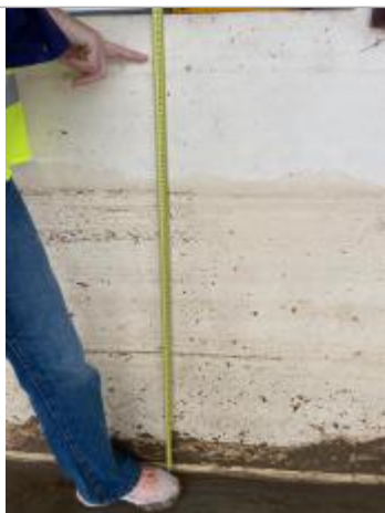
Dépôt de matières solides
