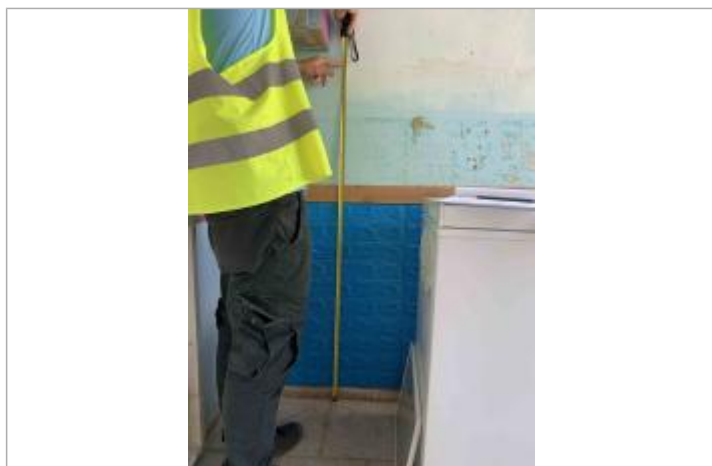
Dépôt de matières solides
