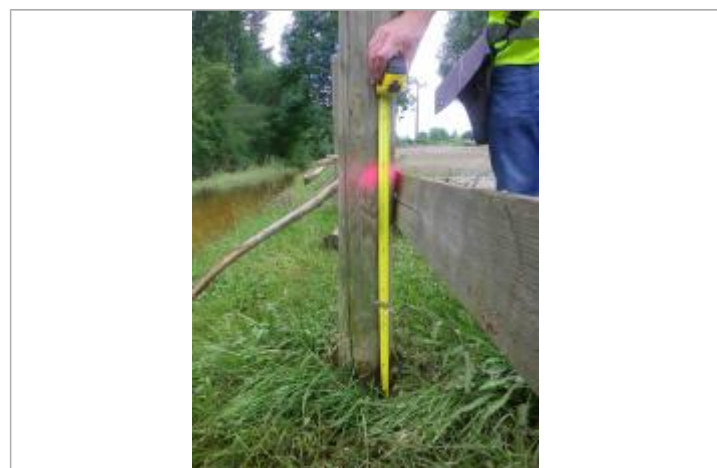
Vue rapprochée du repère à la bombe de peinture sur le poteau en bois (Source : DDT 61)
