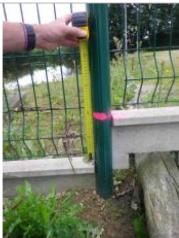
Vue rapprochée de la marque sur le poteau (Source : DDT 61).
