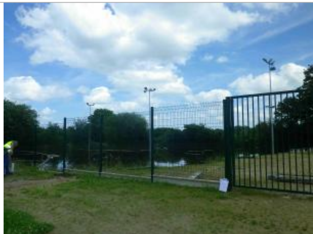
Vue d'ensemble du repère à la bombe de peinture sur le poteau du grillage
