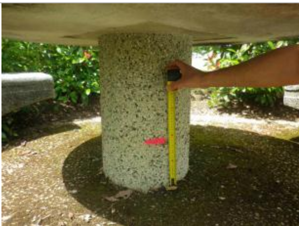
Vue rapprochée de la laisse de crue (Source : DDT 61).
