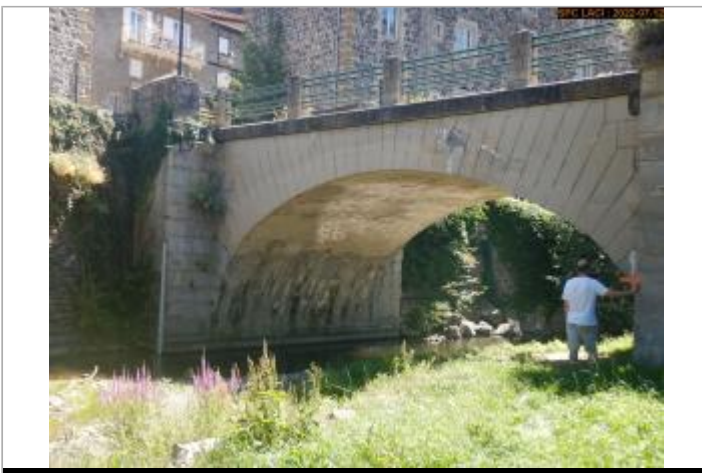
Vue du site éloignée côté aval
