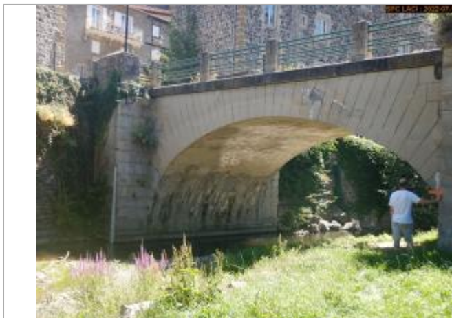
Vue du site éloignée côté aval
