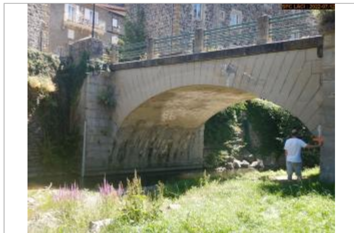
Vue du site éloignée côté aval
