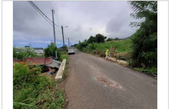
Pont en charge
