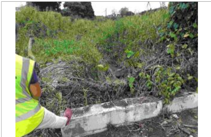
Dépôt de matières solides
