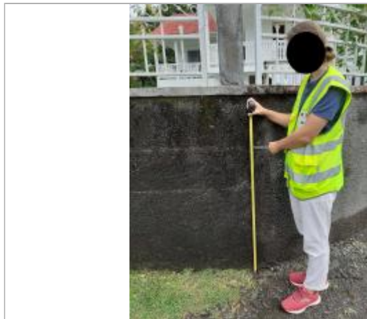
Dépôt de matières solides
