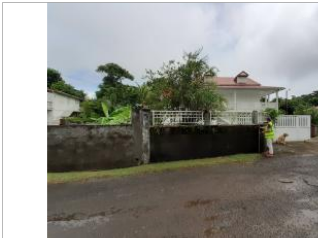
Mur de clôture
